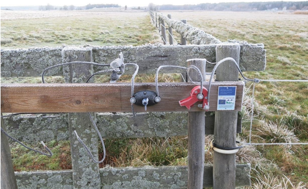
Elcentral där batteri och solcell är monterad (precis borttaget inför vintern).
