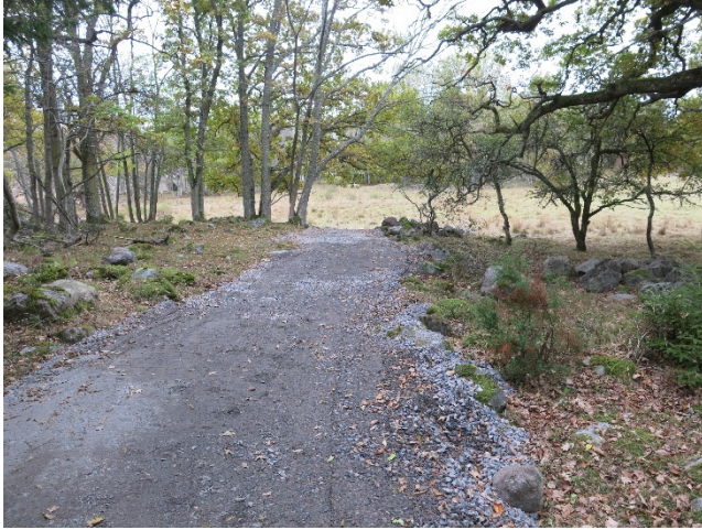
Väg mot ängen färdig.
