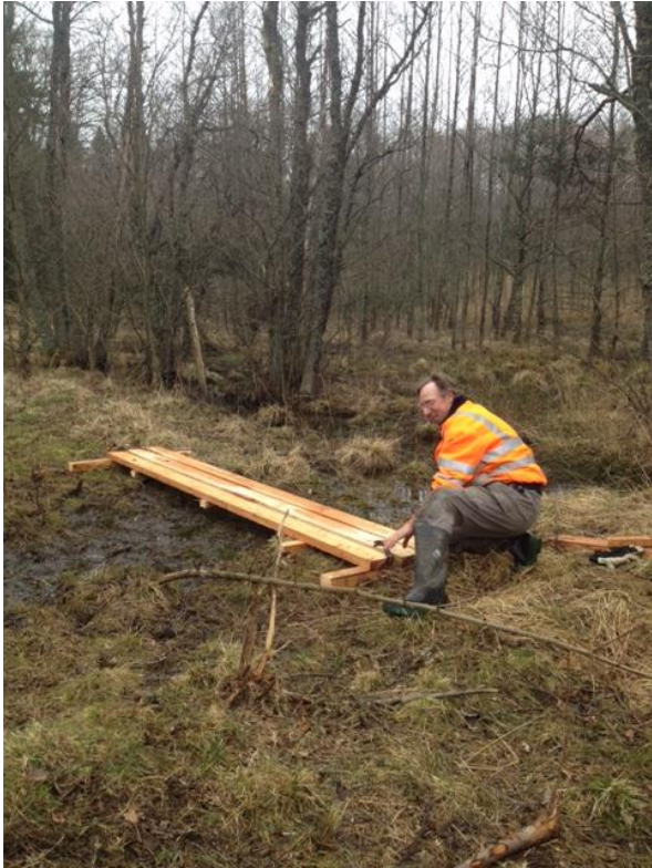
Spång vid Hamngärdet anläggs.
