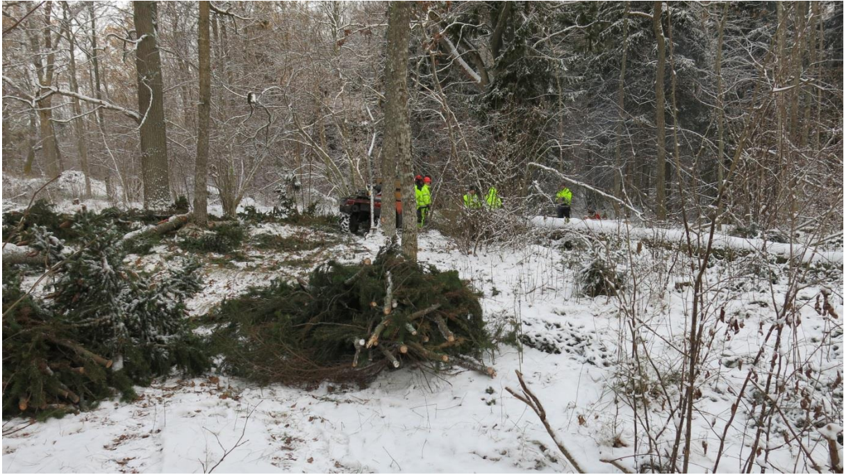
Arbete med att fälla gran och dra ihop ris.
