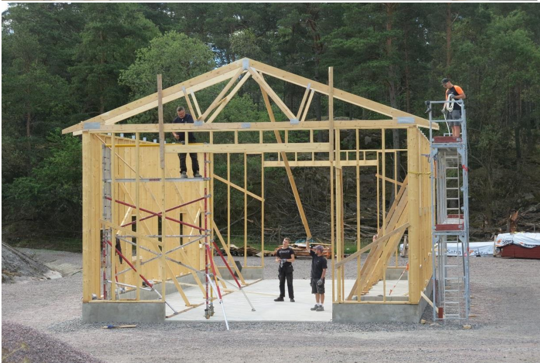
Takstommarna sätts upp.
