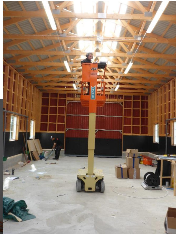
I taknocken har ett genomskinligt plasttak satts in för att möjliggöra mer ljusinsläpp.
