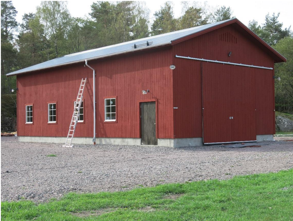
Fårstallet är färdigt! På övre gaveln har extra ventilationshål sågats ut i samma stil som på den gamla ladugården på Rågö. Fårstallet har försetts med skjutdörrar på båda gavlarna, en dörr och rikligt med fönster och belysning. Allt för att få en bra miljö för både djur och människor.
