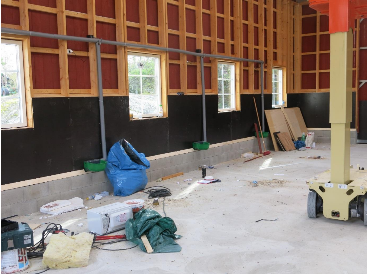
Vattenkoppar på båda sidor av fårstallet har installerats och vattenledningarna har klätts in med isolering för att klara köldgrader utan att spricka.
