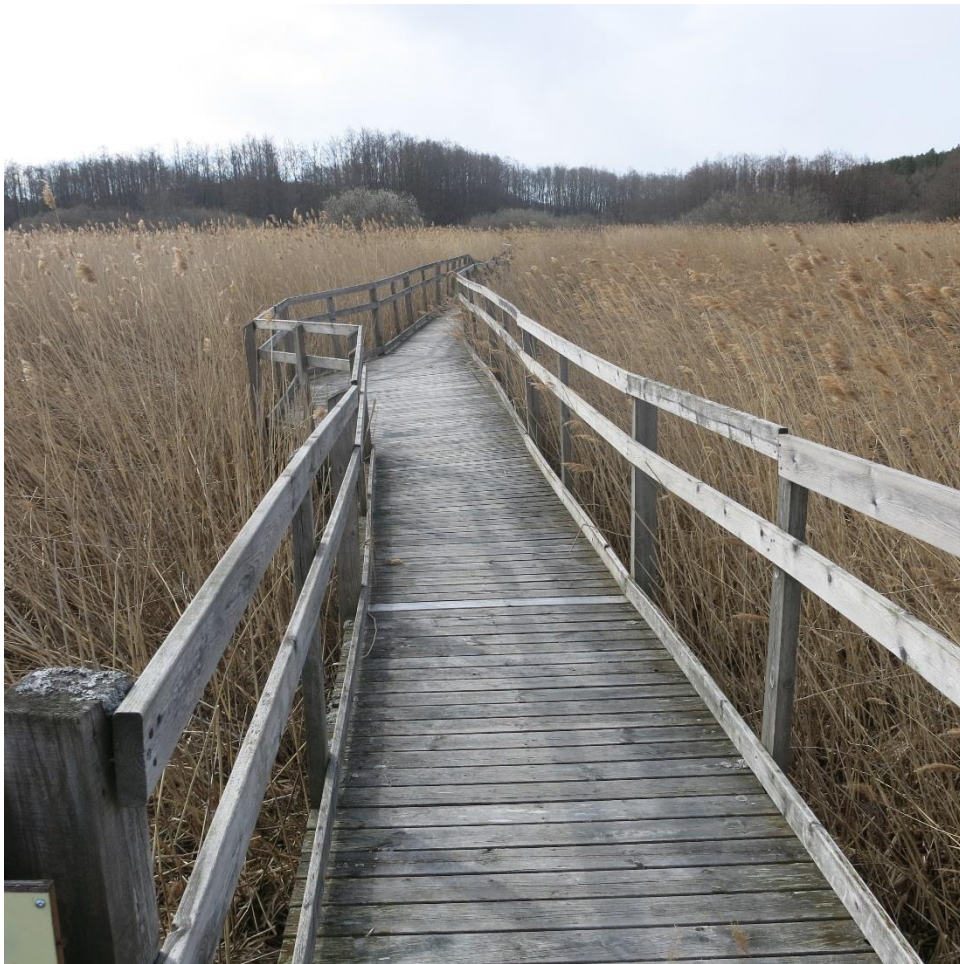
Före: Restaurering av spång.
