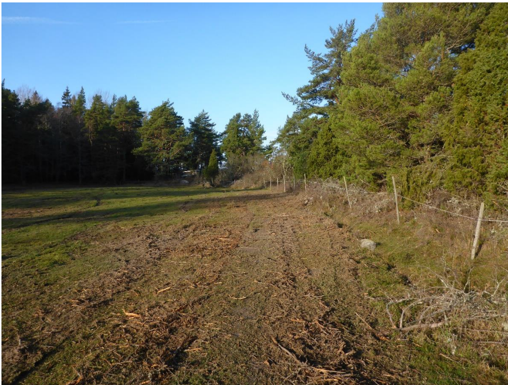
Efter: Yta med slånuppslag fräst. November 2018. (C1_Bråxvik_slånuppslag_efter_MLn.JPG)
