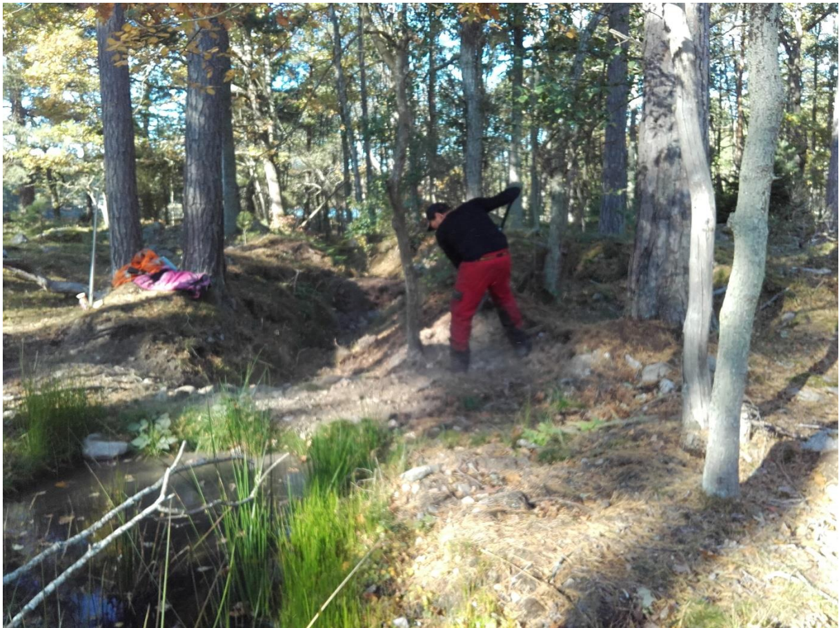
C8 Restaurering av våtmark på Näset Södra Malmö. Diket blockeras med massor som ligger kvar sedan diket grävdes.
