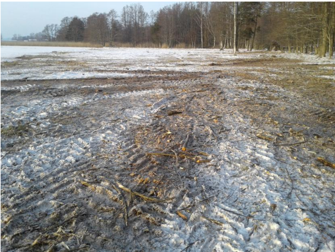
Fräsen körde över sly och stubbar, resultatet blev slätt och fint men med långa pinnar kvar.
