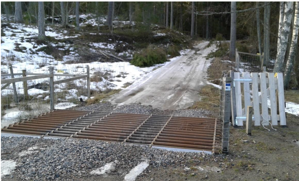
Färstar har grävts ner på Askö. För att underlätta för besökare har självstängande grindar byggts vid sidan om.
