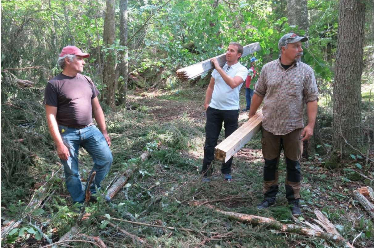
Planering/utstakning av brukningsväg som skall renoveras på Askö. Här vägkäppar som ska utplaceras.
