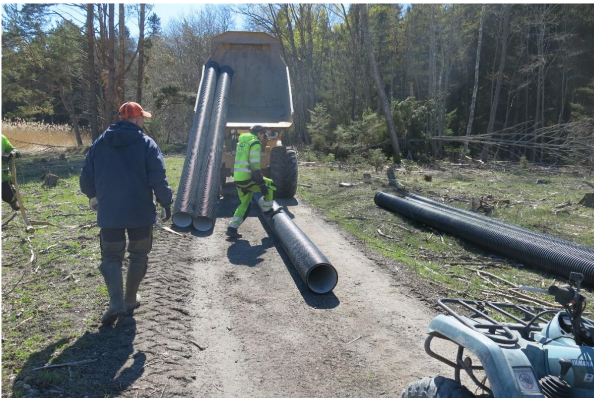
ordningställande av brukningsväg. Vägtrummor grävs ned i brukningsväg för att möjliggöra framkomlighet för jordbruksmaskiner.
