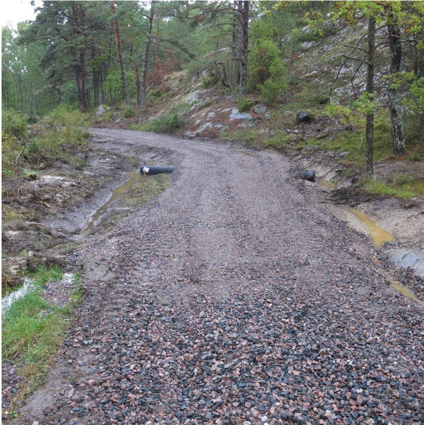
Ny brukningsväg anlagd strax norr om Askö Marina Forskningsstation. Vägtrummor har grävts ner från att dränera vägområdet intill vägen.
