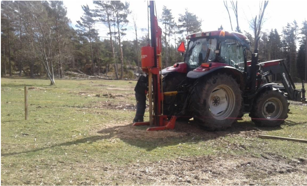
Stolpnedslagning av ängsfålla på Askö av entreprenör Bernt Torelli.
