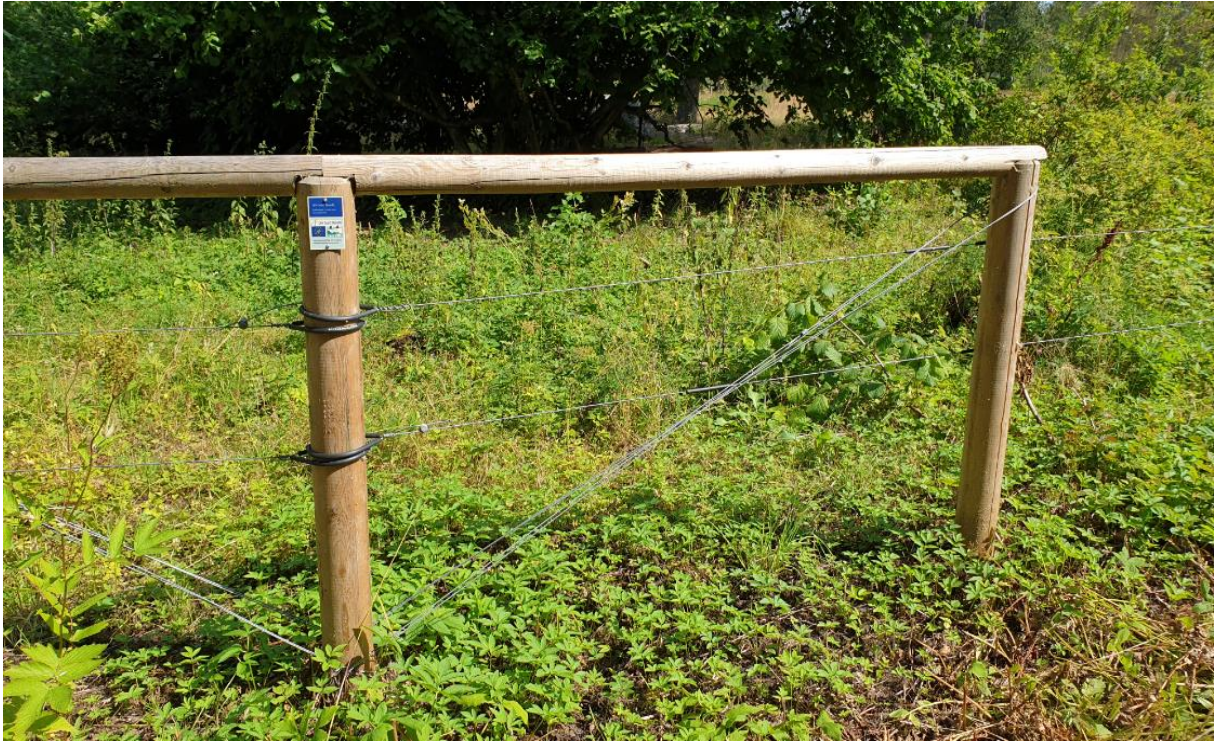
Efter markrestaureringen har stängsel satts upp runt slåtterängen. Här ett hörn där ett s.k. parallelogram byggts.
