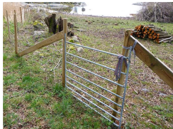
C1 Stängselgenomgångar underlättar för tillgängligheten till områden. Tillfälliga lösningar ibland lämpligt. (C1_Missjö_stängselgenomgång_MLn.JPG)
