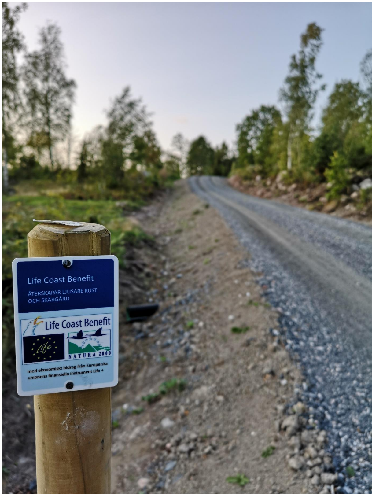
Nybyggd väg till kaj vid Mörkvik som möjliggör transporter till och från skärgården.
