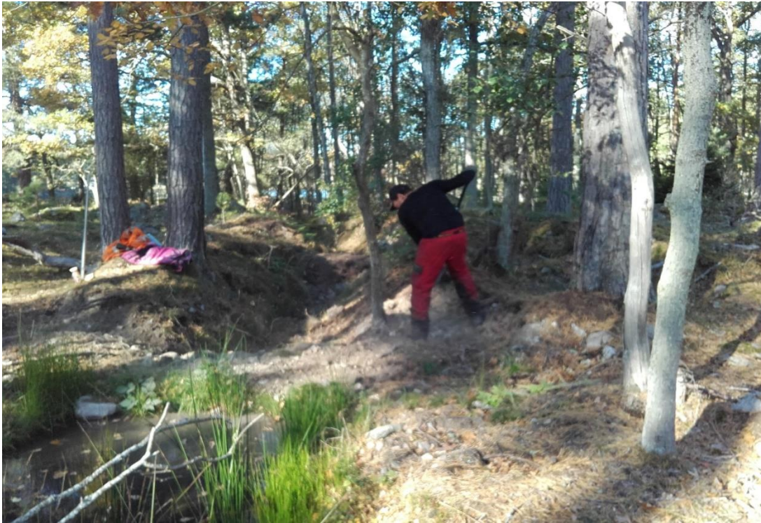
C8 Restaurering av våtmark på Näset Södra Malmö. Diket blockeras med massor som ligger kvar sedan diket grävdes.
